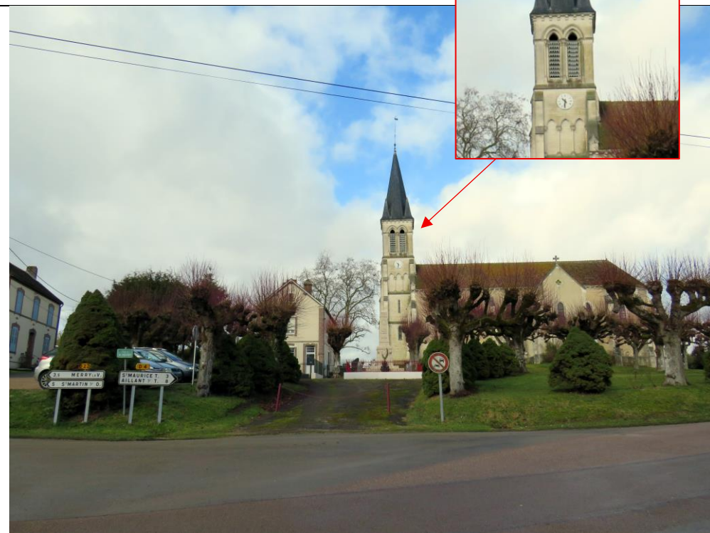
Vue de Près – Après Travaux
